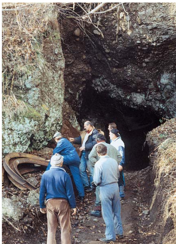
Príprava banských výstuží na klenbu tunela.
