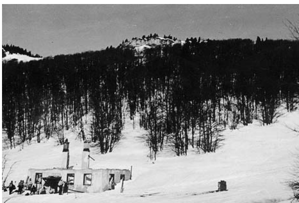
Chata na Kráľovej studni, stav po vojne v roku 1945.
