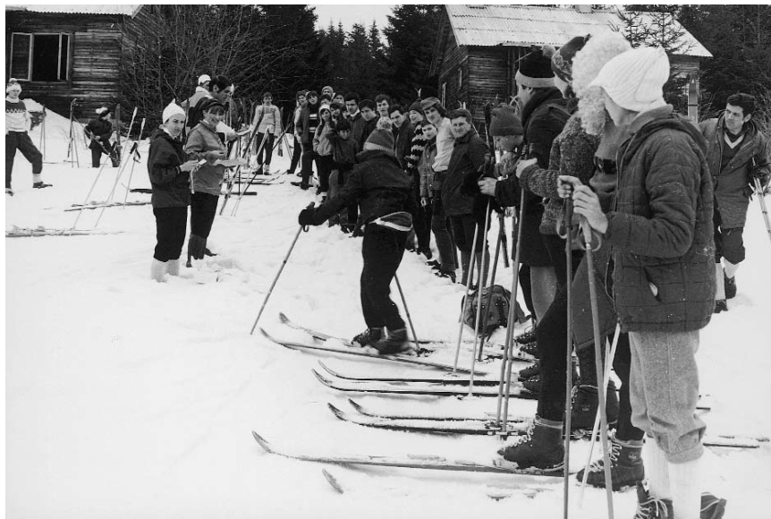
Ciel' 8. ročníka LPPR na Šachtičke, pri rozostavaných chatkách TJ Lokomotíva, v roku 1971.
